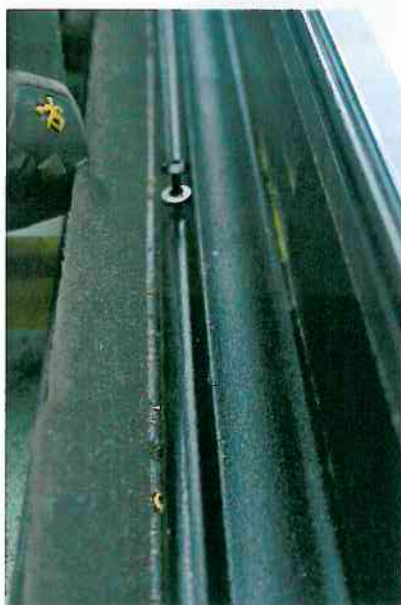
Bevestiging van de collector op de panlatten.
